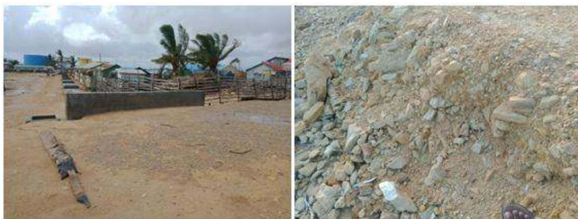
Figure 13: Séchage du varilava et barrière au sol en bois, talus érodé (perte des éléments fins)
