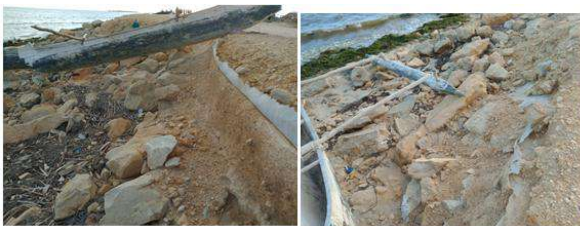
Figure 1 : Erosion des talus et géo-membrane mise à nue et déchirée
