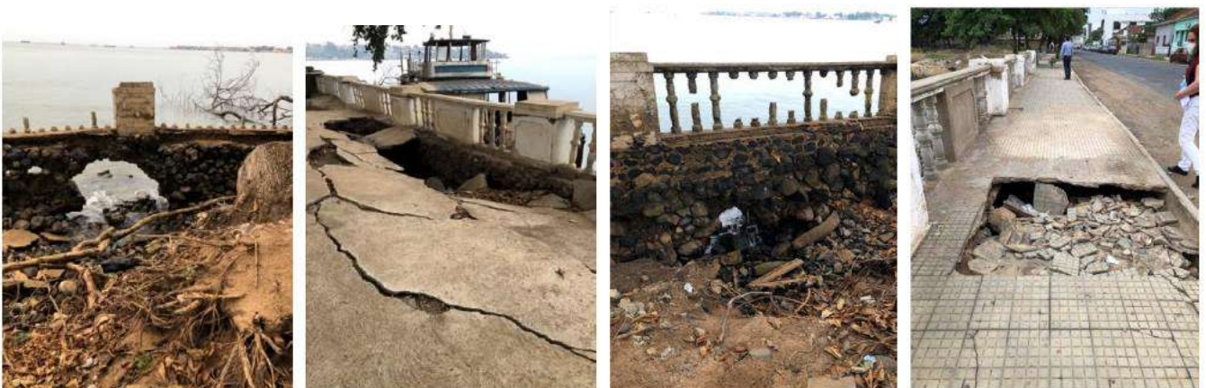
Image 9. Exemple de présence de grands trous dans la chaussée en raison de la perte des fines du remblai. Source : interne
