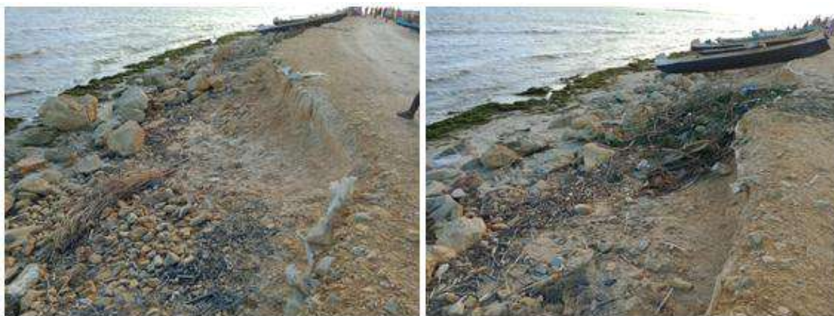
Figure 2: Erosion des talus et géo-membrane mise à nue et déchirée
