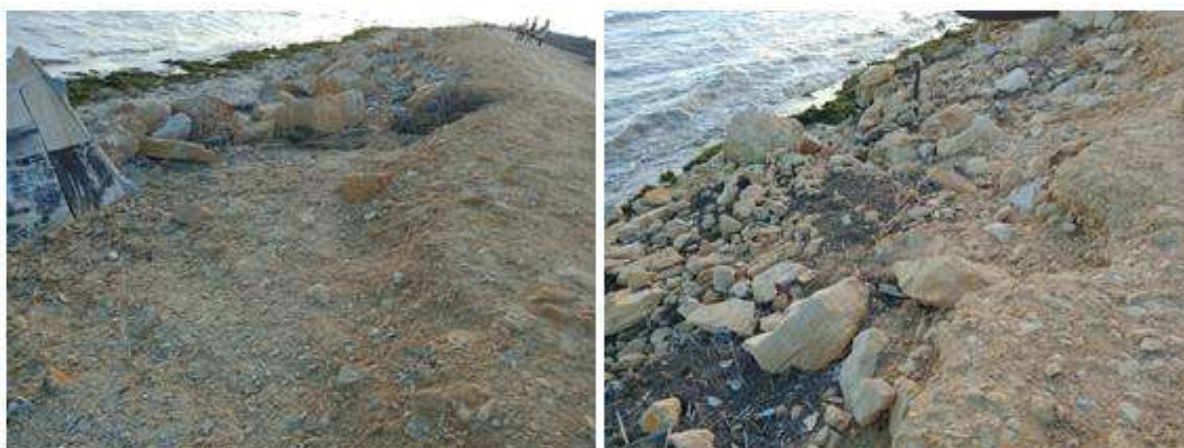
Figure 3: Erosion du talus et disparition des enrochements
