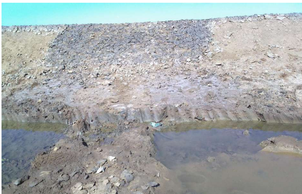
Figure 7 : Digue en terre pour la protection de la zone de production de sel des eaux de pluie et de la mer
