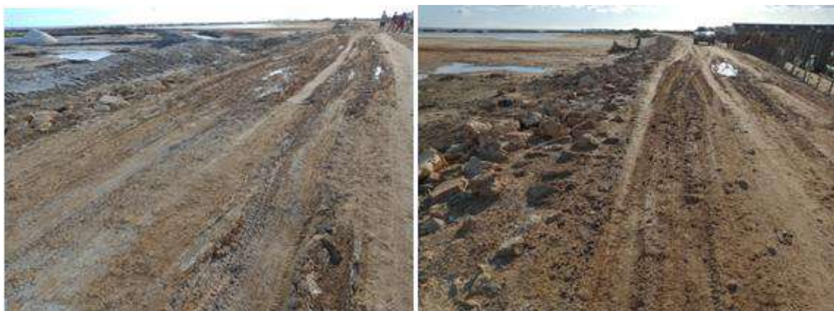
Figure 11: Dégradation de la voie d'accès (ornières, nid de poule)
