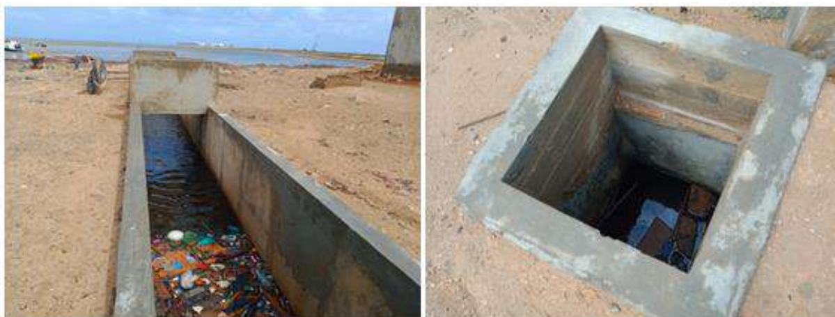
Figure 6: Exutoire et regard de la vanne n°01
