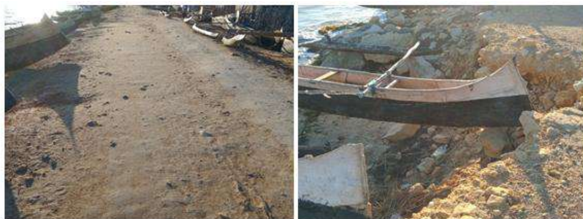
Figure 9: Erosion du talus, disparition des enrochements, ravinements
