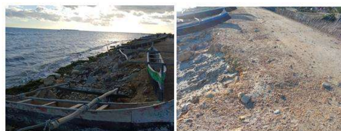
Figure 4: Erosion du talus et rétrécissement des chaussées
