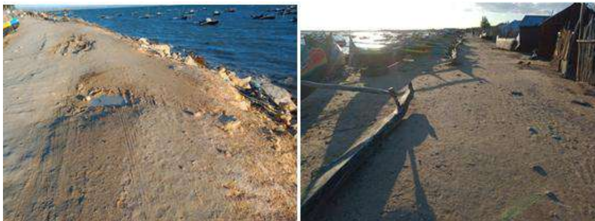
Figure 12: Nids de poule, rétrécissement de la route
