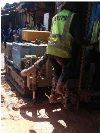
Sondage à la tarière mécanique
