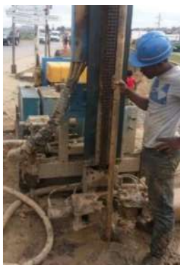
Sondage mécanique
