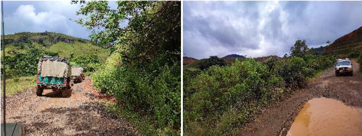
Photo 6. Aperçu de la largeur actuelle (3m) sur quelque tronçon de la route
