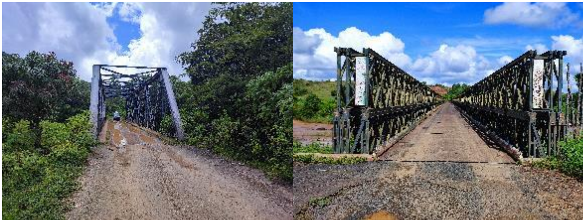
Photo 7. Ponts existants à démolir et à remplacer en pont en BA
