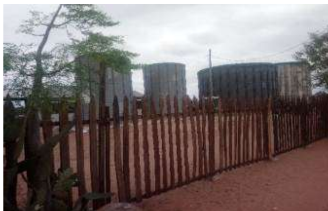
Photo 29. Site de stockage de Phileol à Tsihombe
