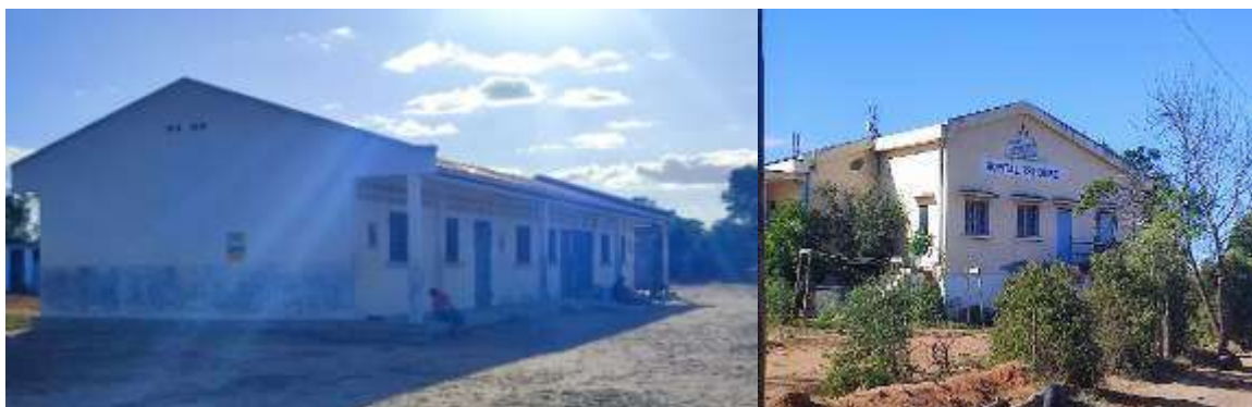
Photo 23. Clichés du CSB II à Kopoky (à gauche) et du CHD à Tsihombe (à droite)
