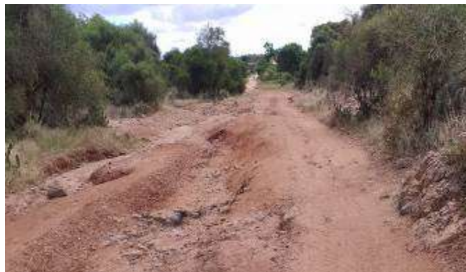
Accès vers la carrière C7S3
