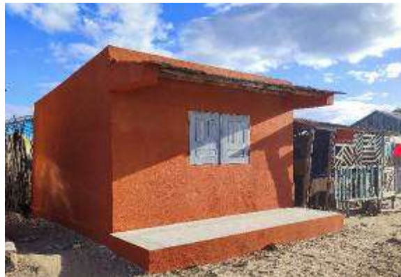
Photo 19: Construction en dur à Kopoky
