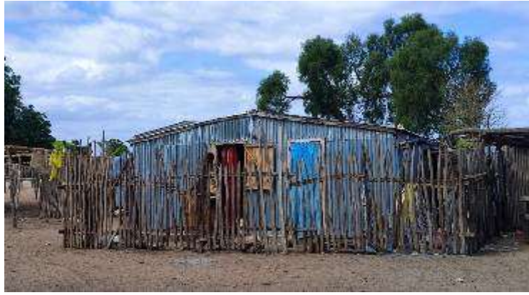
Photo 18: Type de construction en tôle
