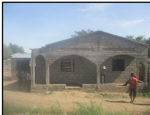
Photo 13 : Mur en parpaing, sol cimenté, toiture en tôle
