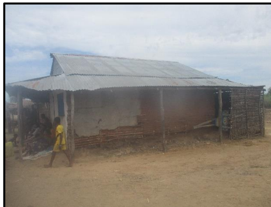
Photo 16 : Mur en terre battue, sol nu, toiture en tôle
