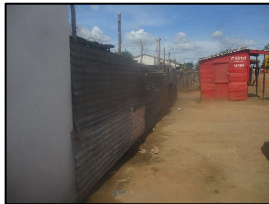
Photo 21 : Clôture en tôle
