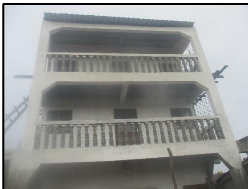
Photo 12 : Maison à étage, mur en brique cuite, sol cimenté, toiture en tôle
