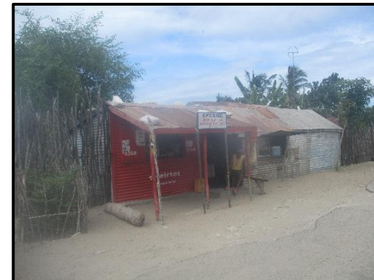
Photo 14 : Mur en tôle, sol cimenté, toiture en tôle
