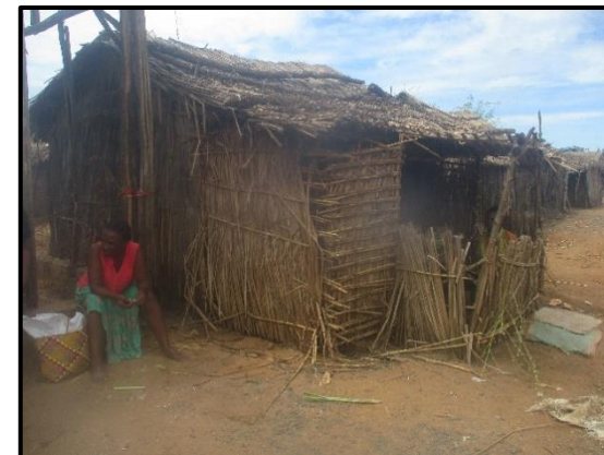
Photo 17 : Mur en paille, sol nu, toiture en chaume
