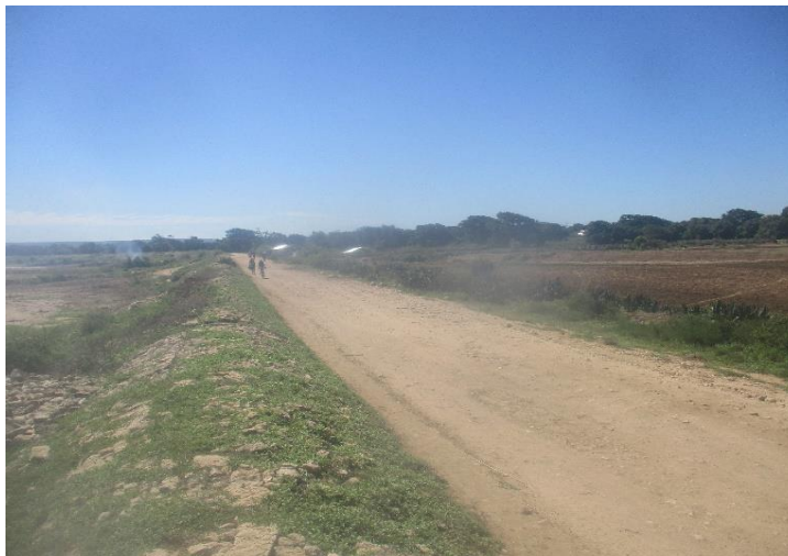
PHOTO 1 : ABSENCE DE SYSTÈME D'ASSAINISSEMENT
