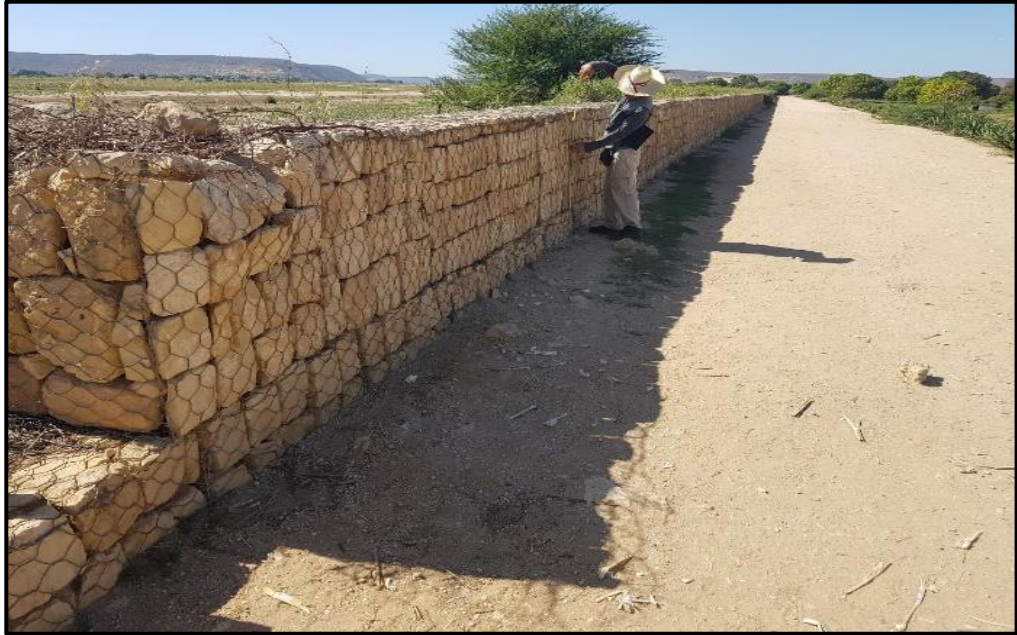
PHOTO 7 : MATELAS DE GABIONS SUR LA DIGUE
