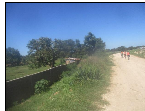
Photo 15 : Clôture en brique
