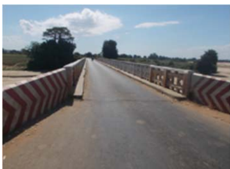
Photo 2 – Vue amont du pont de Manombo
