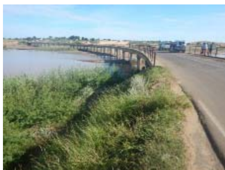
Photo 1 – Vue amont du pont de Belalanda
