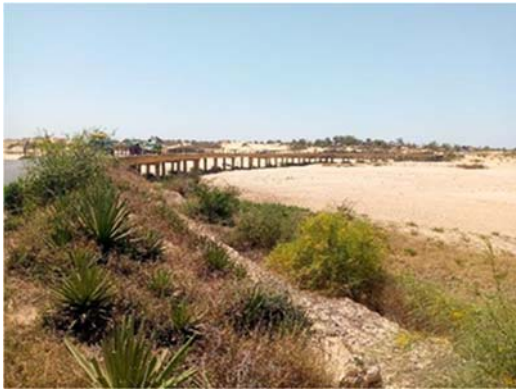
Photo 8 : Localisation de la zone du projet - Pont de Belalanda
