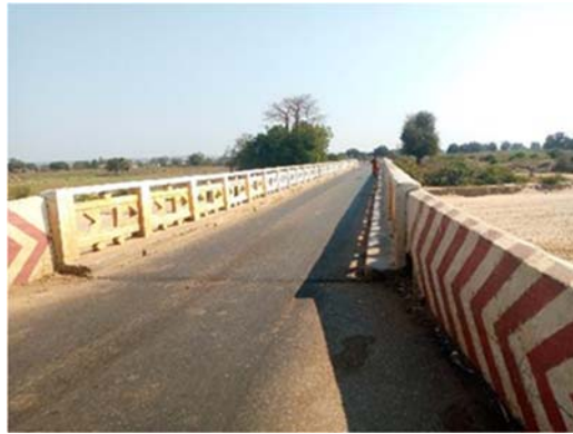
Photo 9 : Localisation de la zone du projet - Pont de Manombo
