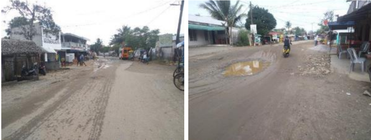
Emprise de la RN 5 à Foulpointe
